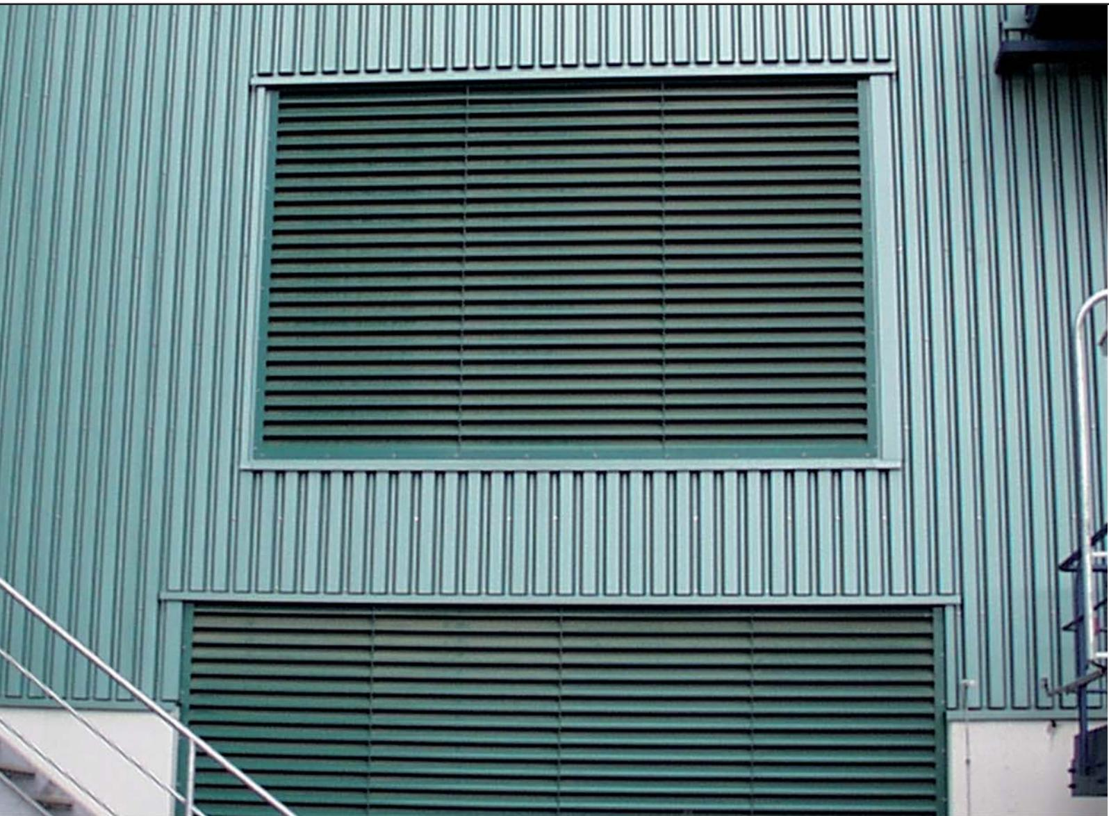
Ilustración grande: Entradas de aire tipo AIRJET
