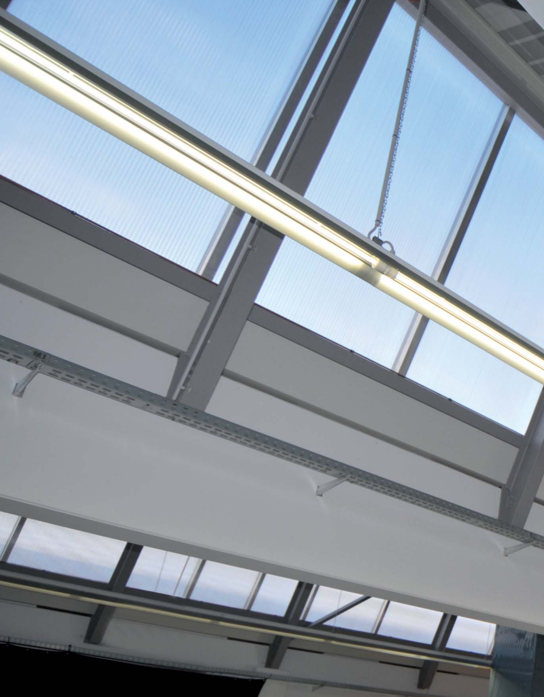
Imagen: Lucernario orientado al Norte en una fábrica textil.
