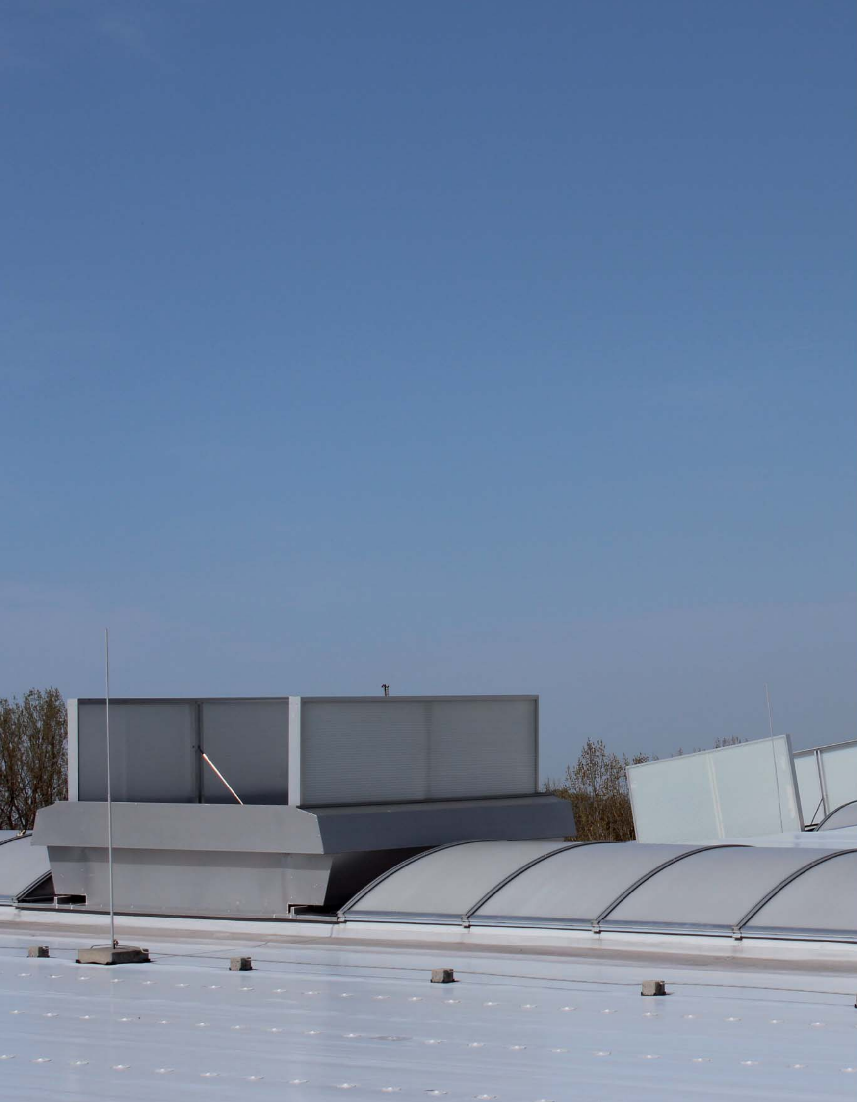
Imagen: Aireadores naturales MEGAPHOENIX y PHOENIX integrados en un lucernario EUROLIGHT.
