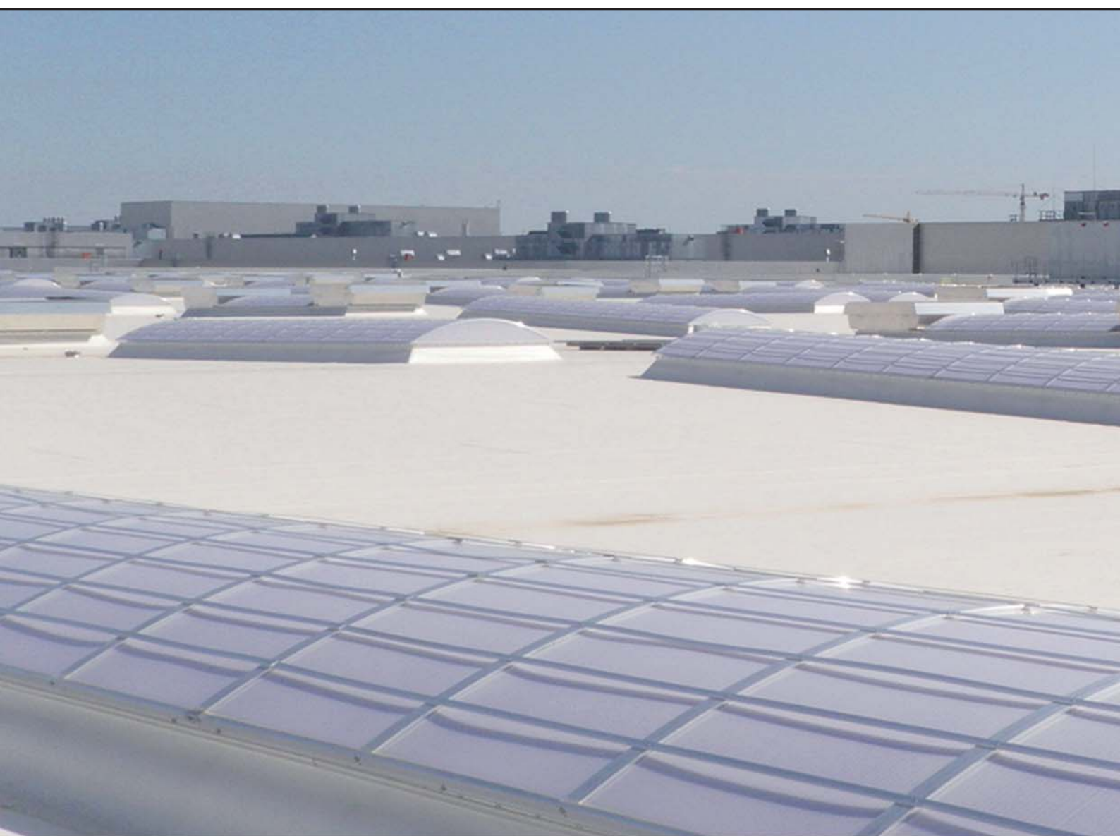
Lucernarios EUROLIGHT con protección anti caídas tipo PSP30 en una gran nave de producción.
