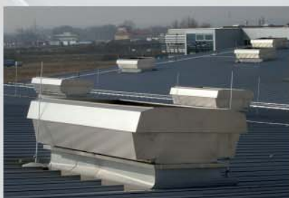
Instalado sobre cubierta trapezoidal
