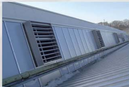
...y después de la reforma.
