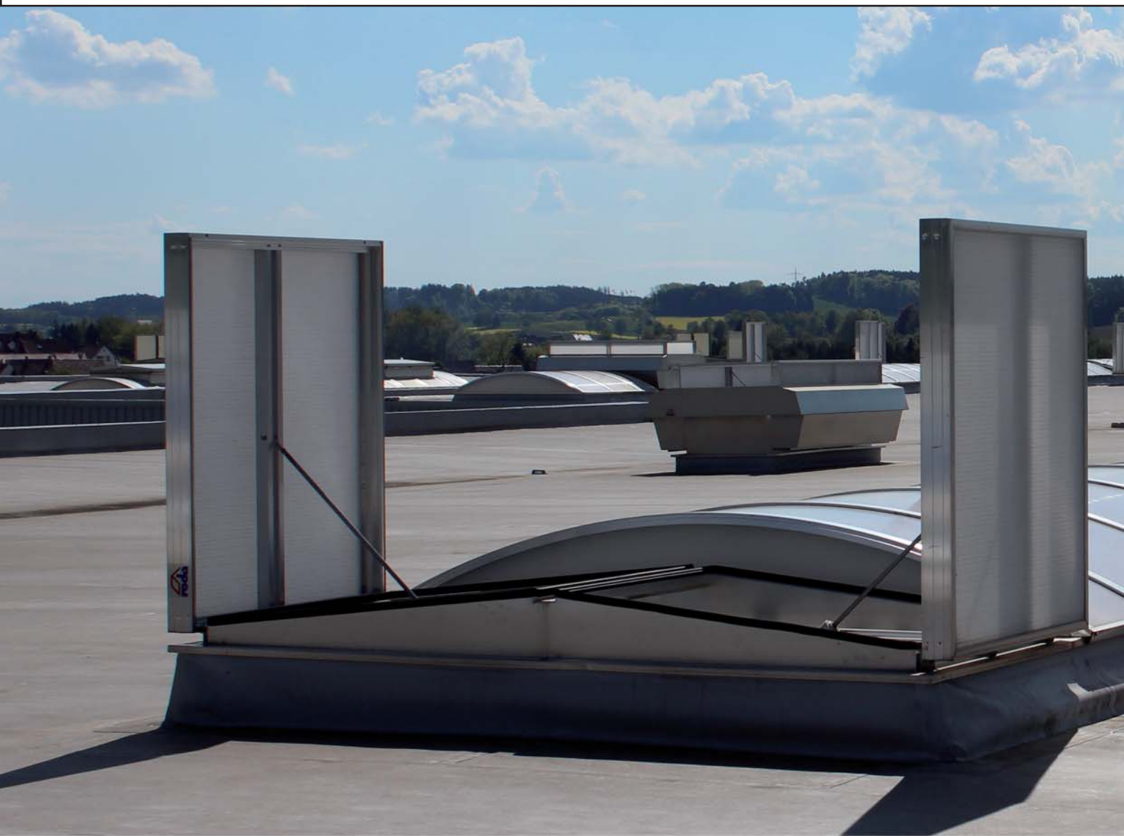
SCTEH tipo PHOENIX instalado en el extremo de un lucernario tipo EUROLIGHT.
