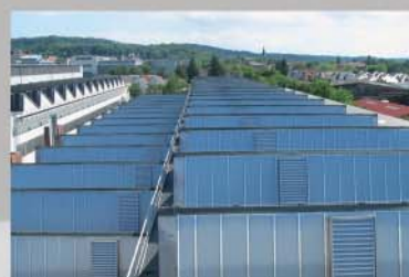
Instalación en cubierta shed
