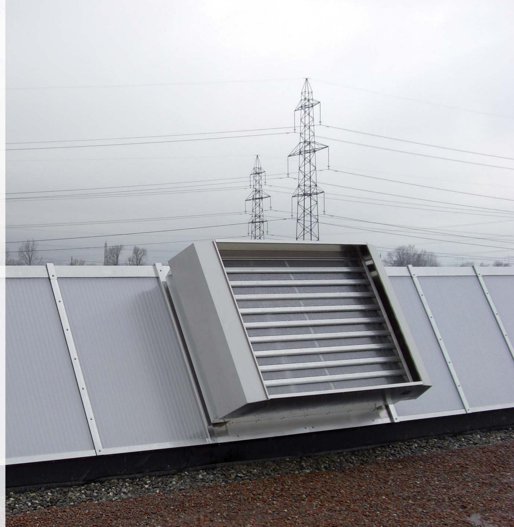
SCTEH y aireador multifunción modelo MULTIJET montado sobre lucernario inclinado.
