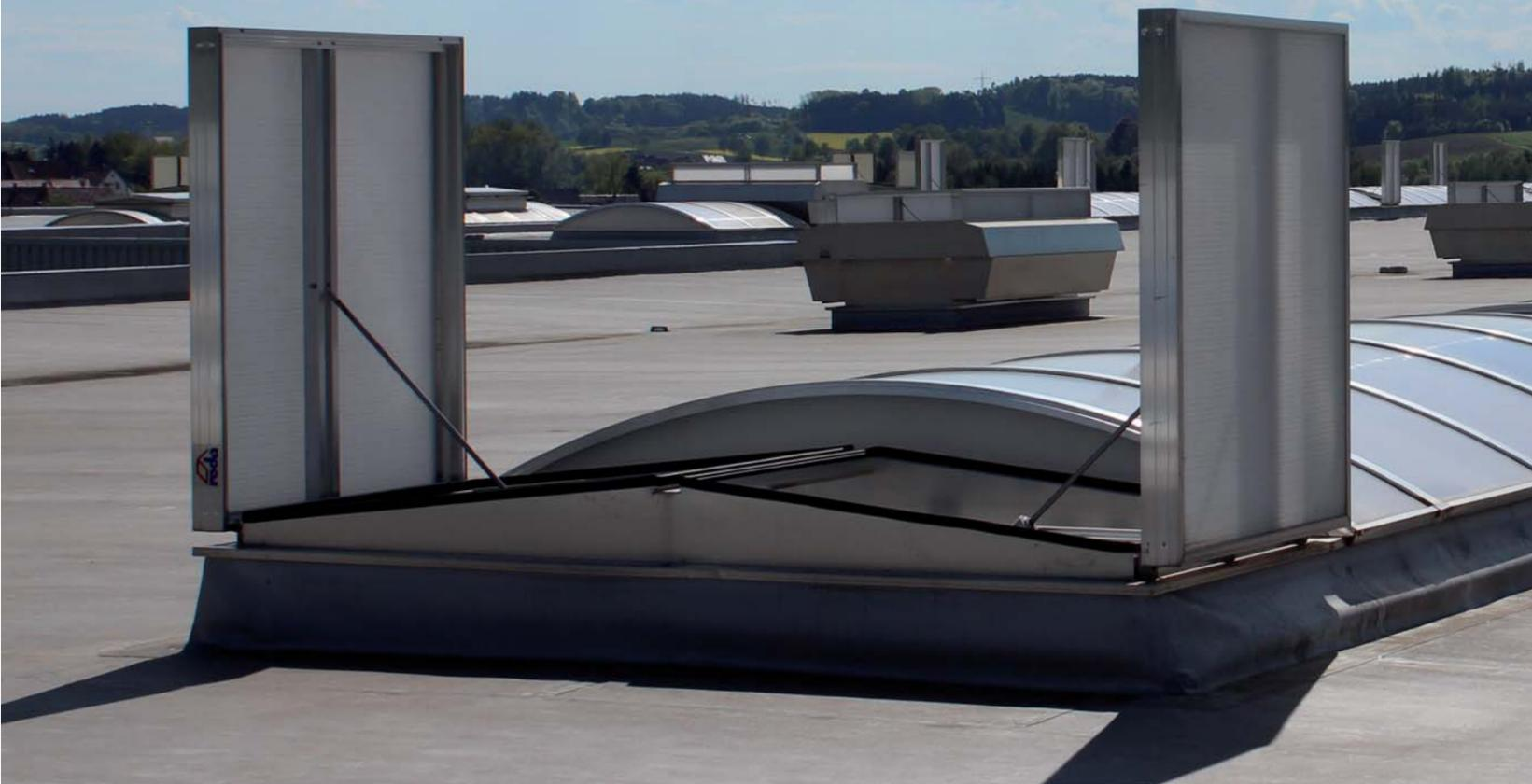
SCTEH tipo PHOENIX instalado en el extremo de un lucernario tipo EUROLIGHT.
