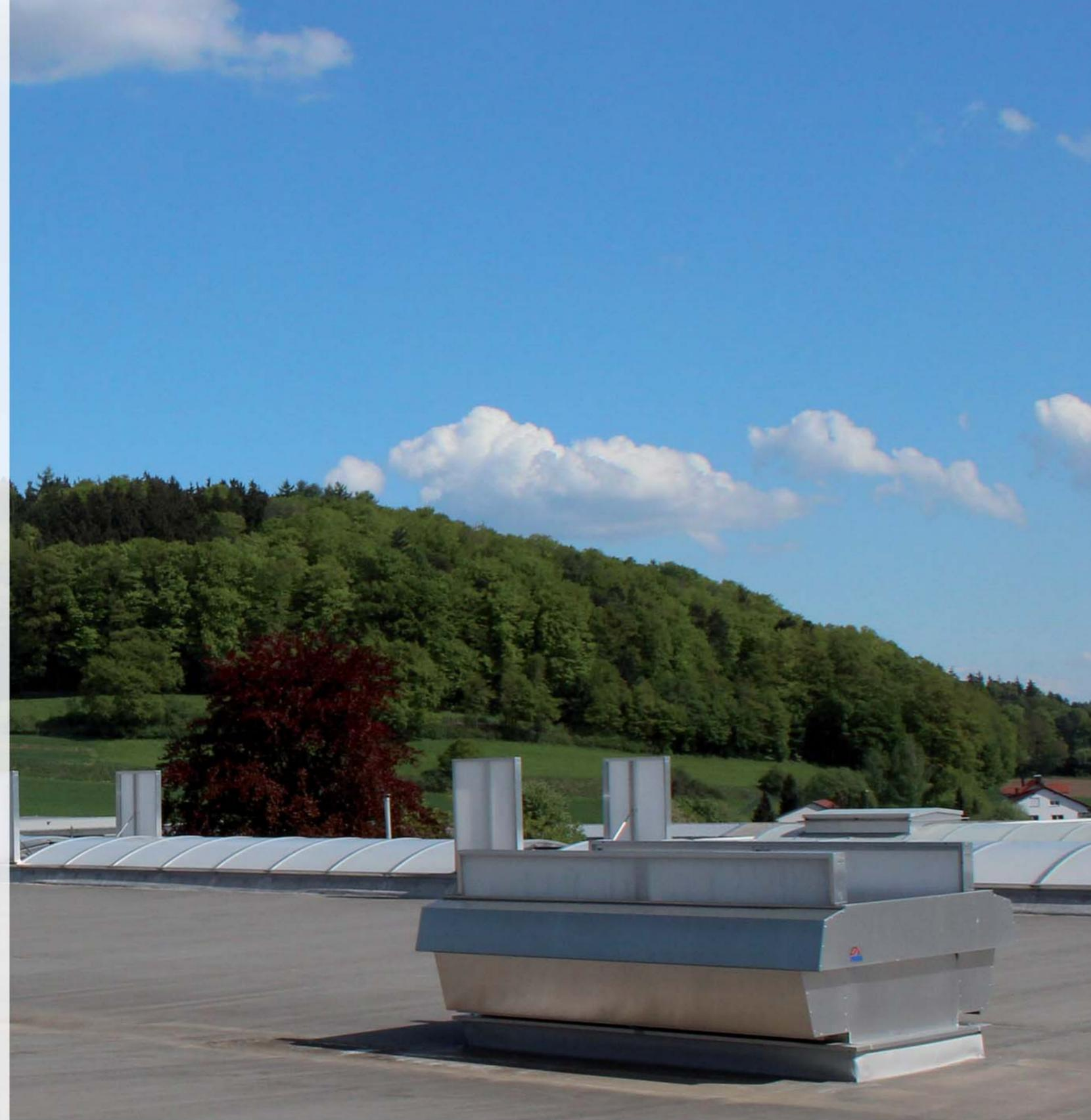
Aireador multifunción y SCTEH tipo MEGAPHOENIX en la cubierta de una nave de producción.
